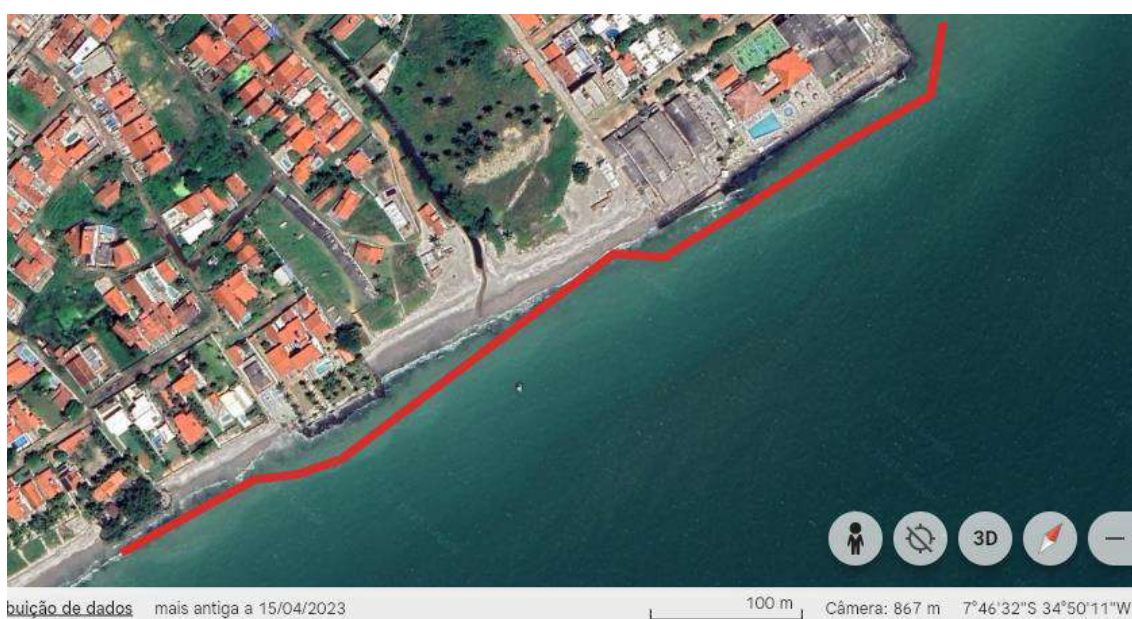
Figura 19: Trecho 1 da área do Forte, que sofre com o avanço do mar.
