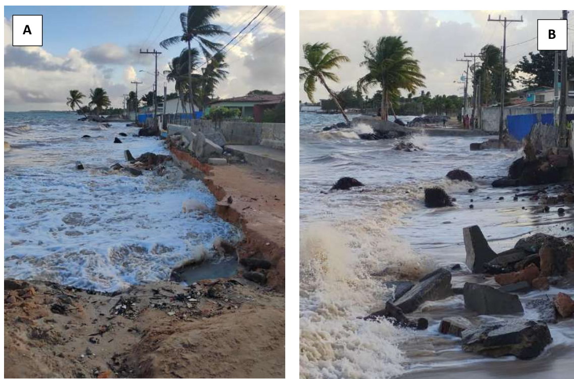
Figura 16: Imagens registrada no Rio Âmbar, na Av. Beira Rio, na Ilha de Itamaracá, no dia 02/03/2025, durante a preamar de 2,7m (A) e a imagem B, registra a vazante do mesmo local (Imagens: André Priem).
